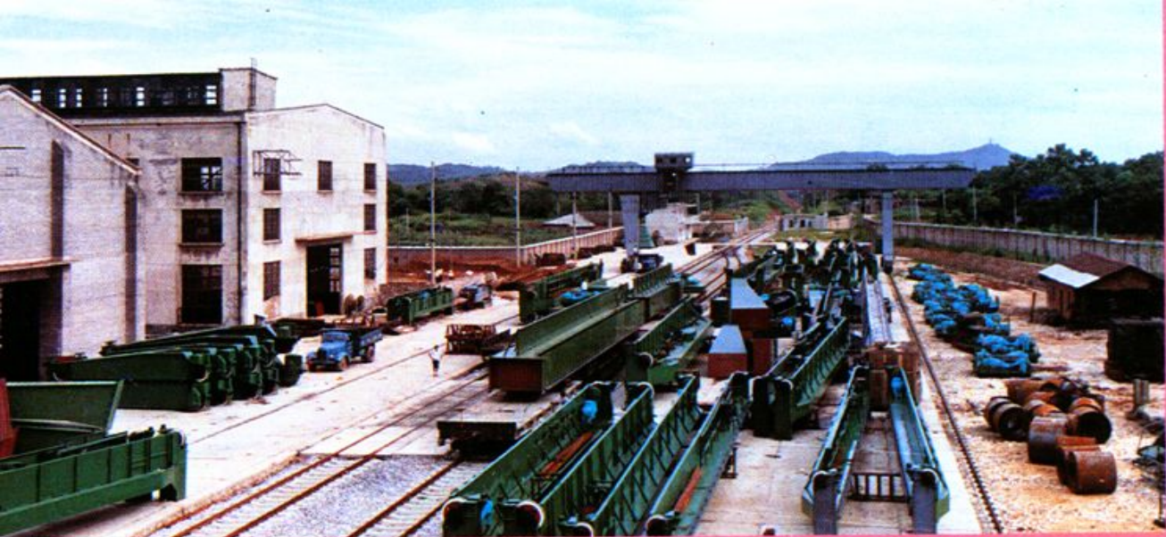
自營鐵路專用綫站台及大型金結構廠房
