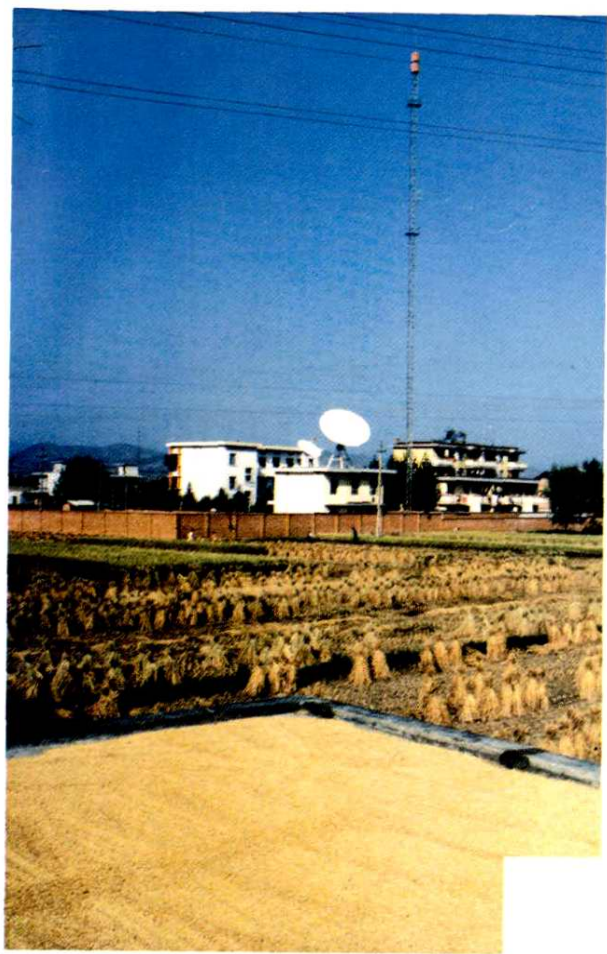
洋县卫星电视地面接收站
