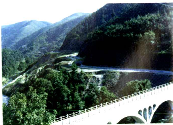
洋(县)—华(阳)公路
