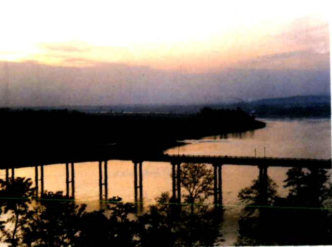
洋县汉江大桥
