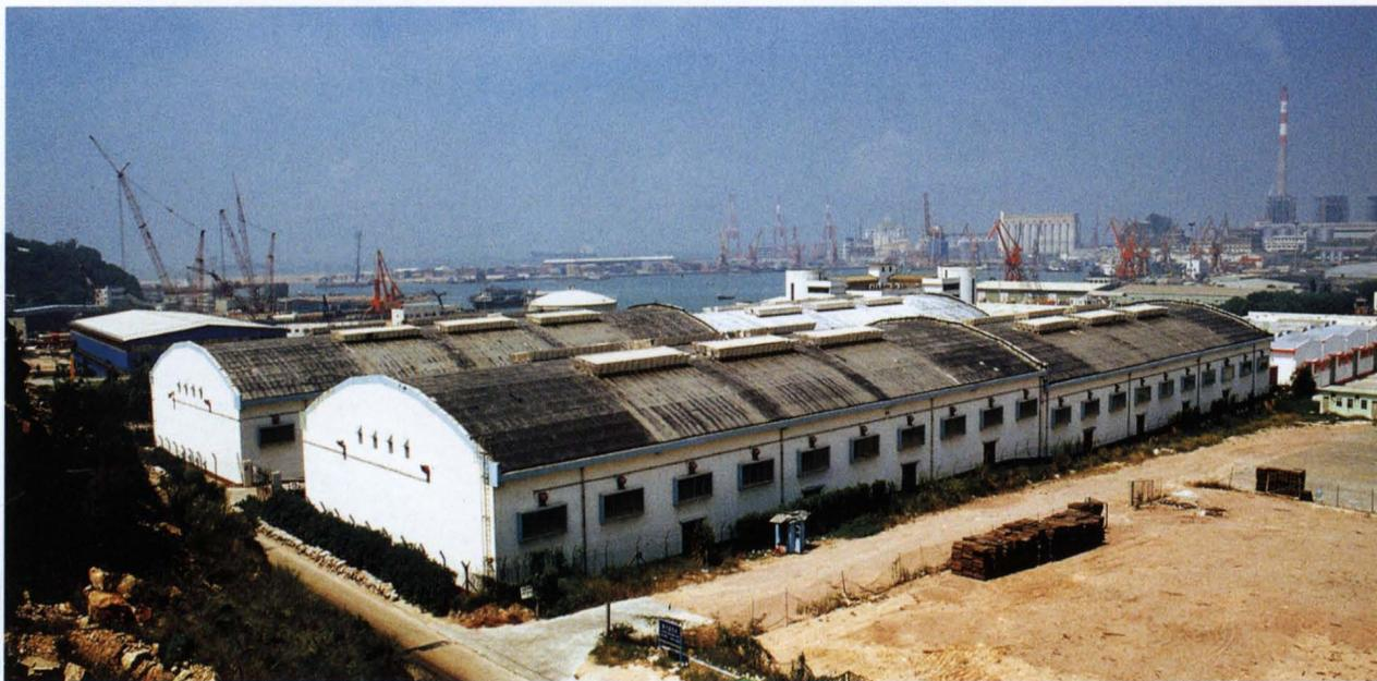
1990年承建的赤湾G1G2仓库, 施工中成功采用大跨度36米预应力混凝土屋架, 取得良好效果。
