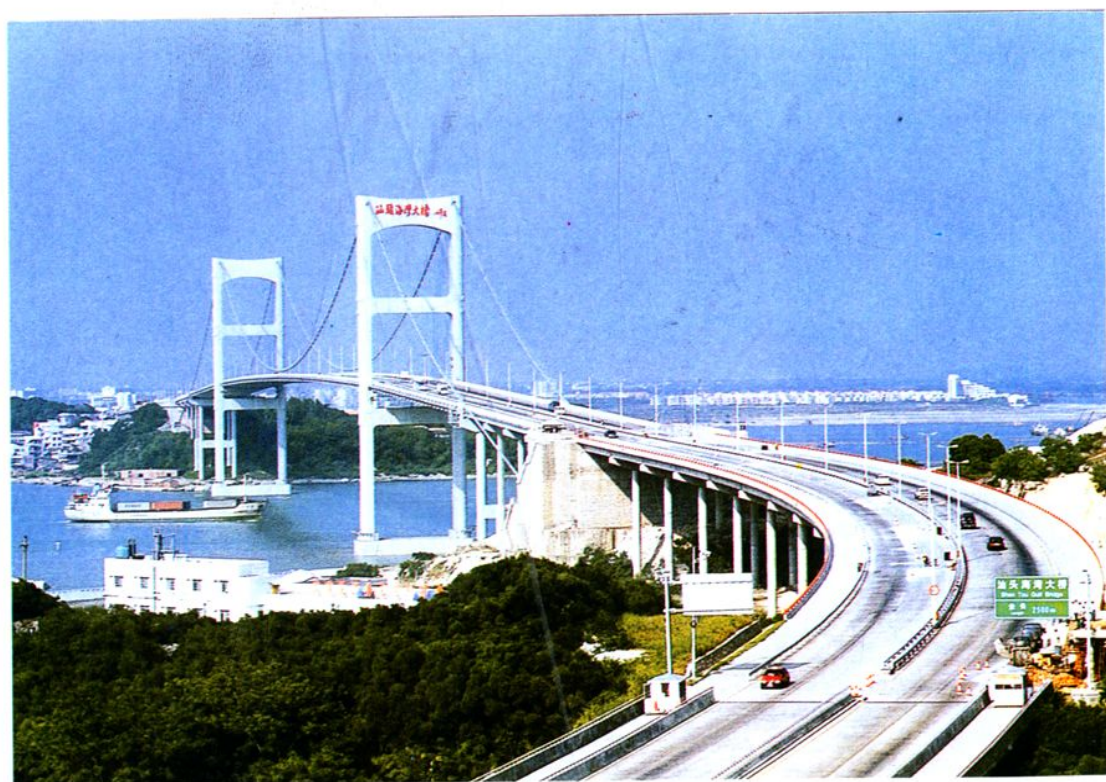
▲ 汕头海湾大桥
