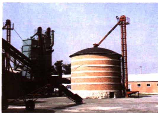
鞍山市第七粮库粮食烘干塔等设备
