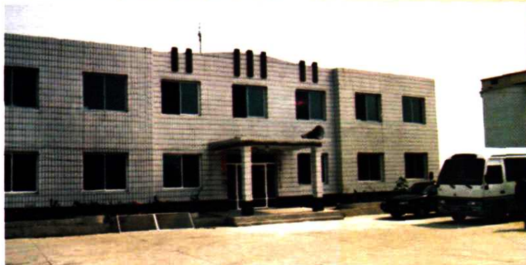
鞍山市第七粮库办公楼
