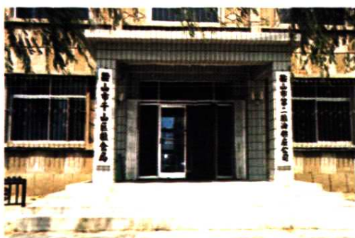
千山区粮食局办公楼
