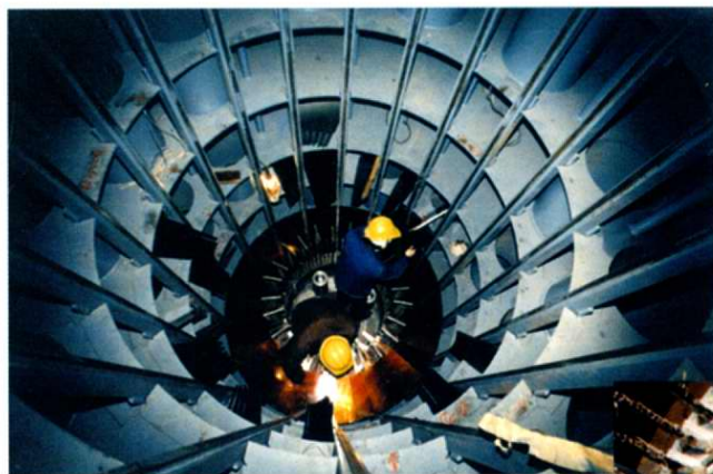
抢修320MW汽轮机转子
