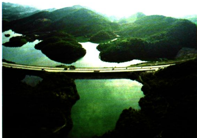
► 穿山越水的长潭高速公路
