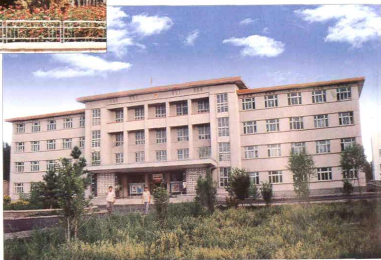
▼ 额敏县人民政府机关办公大楼(1990 年)
