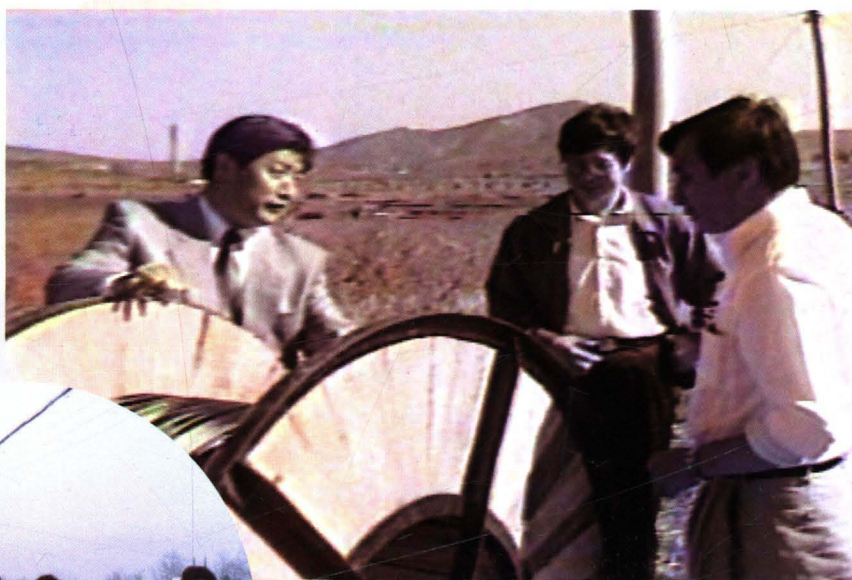
1996年，文登市委书记刘国信（左一）亲临有线电视施工现场考察
