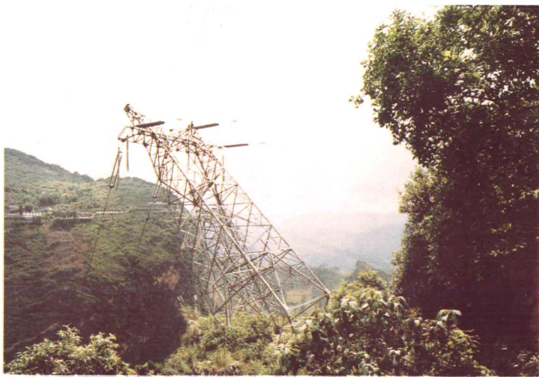
鲁布革电厂出线斜塔
