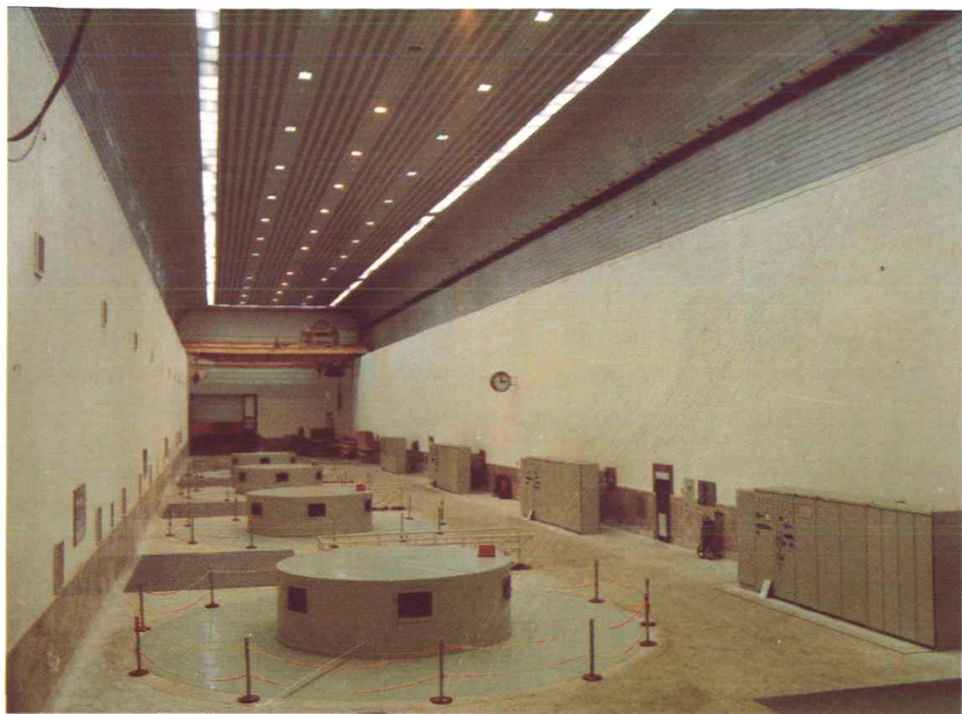
鲁布革电厂地下厂房
