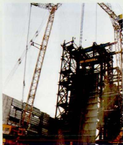
太原第一热电厂五期扩建工程(2×30万kW)安装锅炉水冷壁
