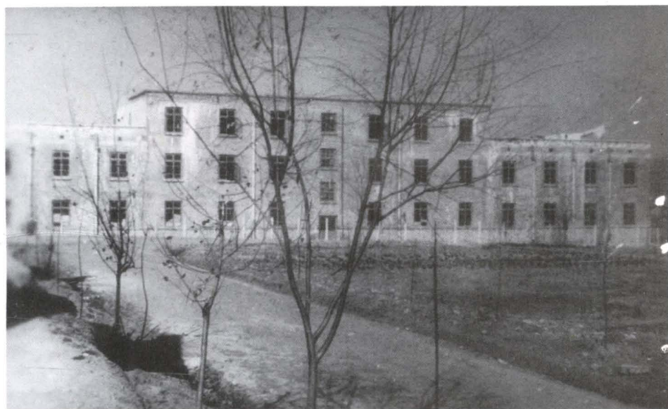
移交接收的办公大楼
