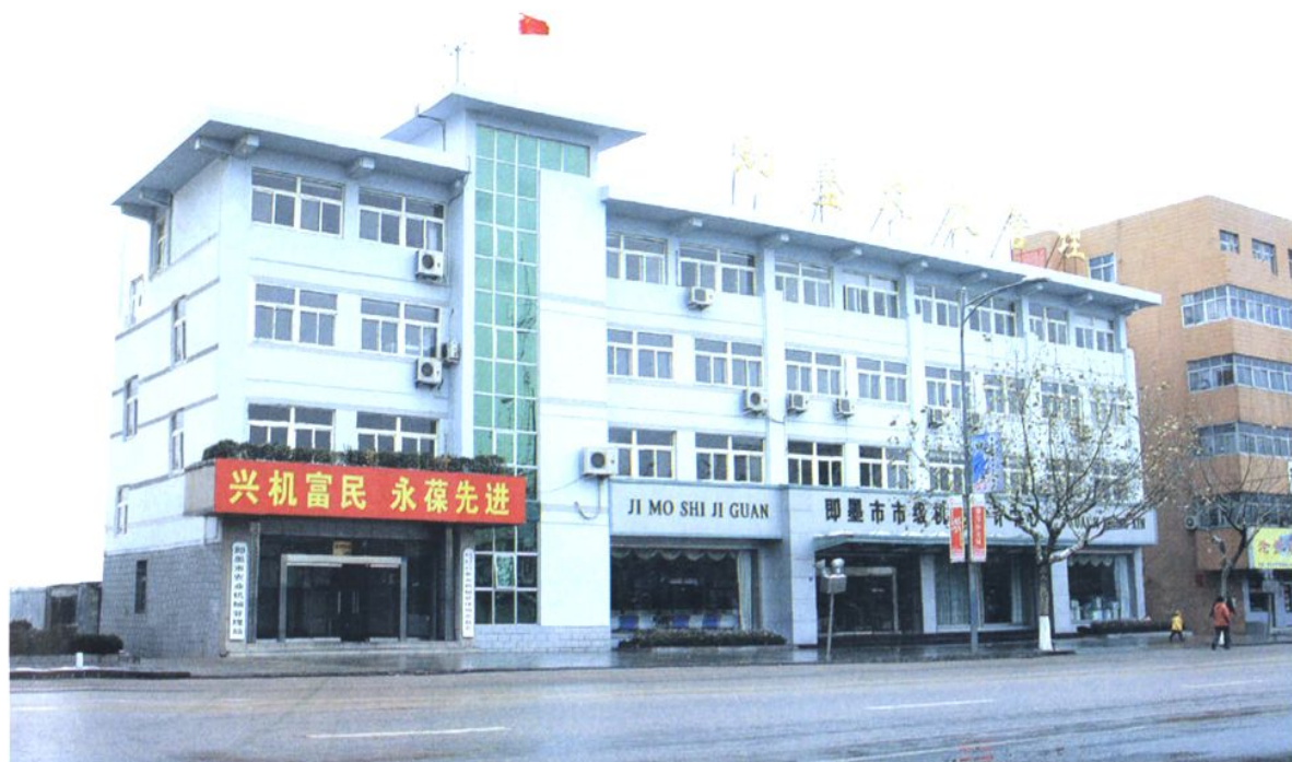
即墨市农业机械管理局办公大楼
