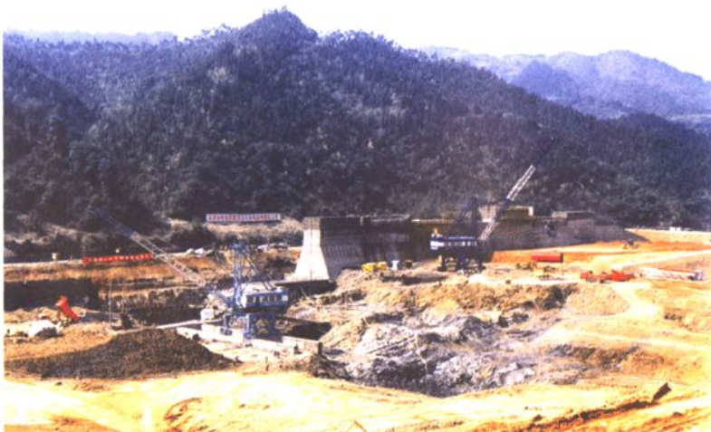
投资7亿余元、正在建设中的平乐巴江口水利枢纽工程
