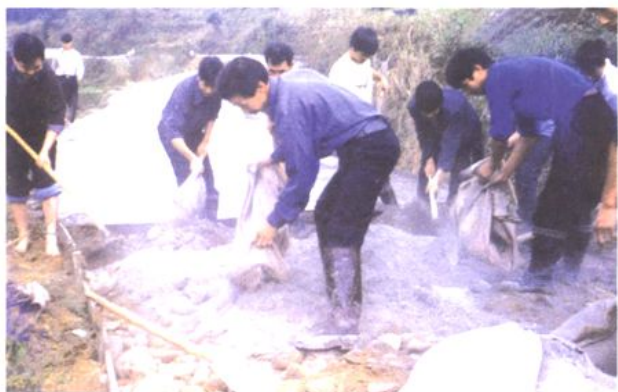
村道铺设水泥混凝土路面
