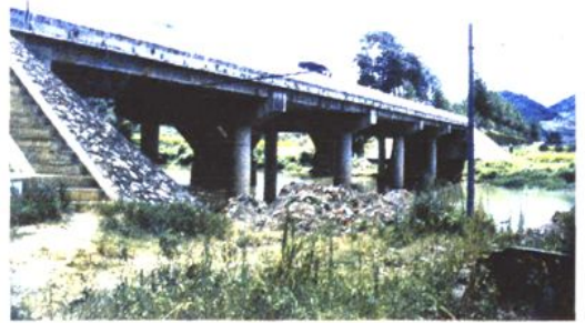
1999年建成的国道线榕津新大桥
