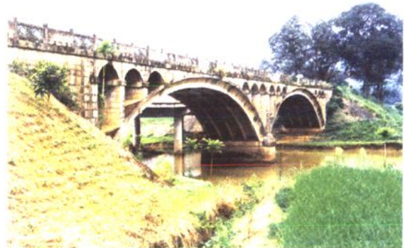
1972年建成的国道线榕津大桥
