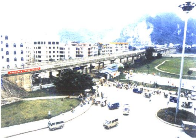
1990年建成的国道线平乐桂江大桥
