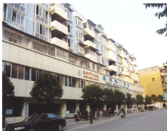
北河街门诊部
