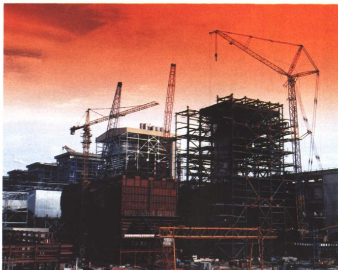
● 邹县电厂三期工程2台60万千瓦 机组建设
