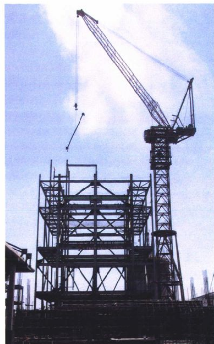
● 淄博热电公司热电工程安装2台465吨/时循环流化床锅炉。图为工程建设现场
