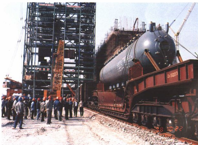
● 莱城电厂一期工程4台30万千瓦 机组建设
