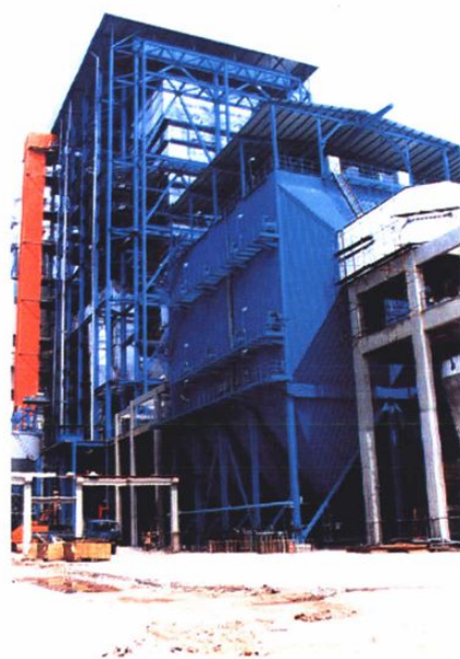
● 四川广安公司二期工程2台30万千瓦机组正在建设
