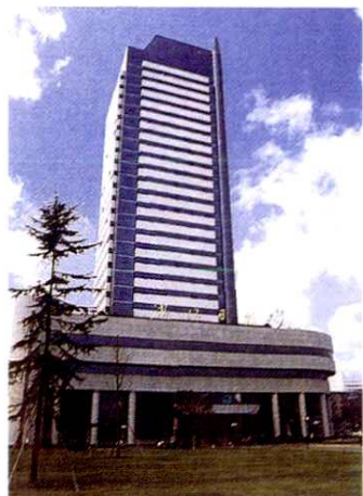
▲浙江日报新闻大楼基础工程
