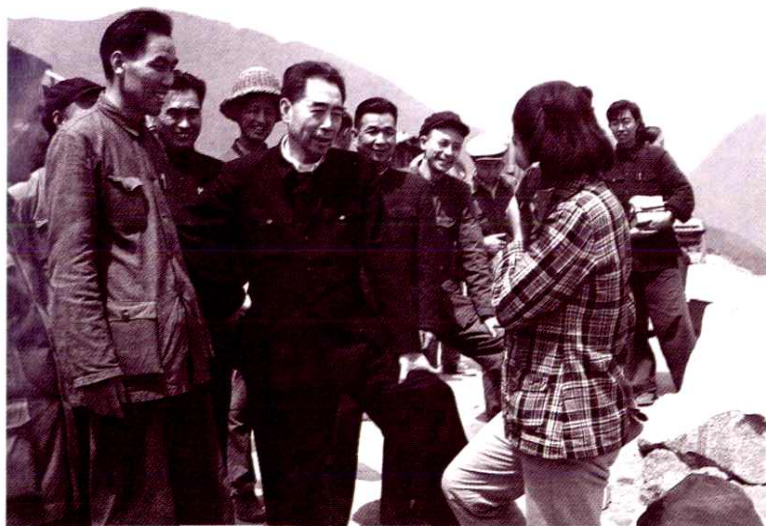
▲ 1959年4月，周恩来总理视察新安江水电站工地（徐欣葆摄影，新安江电厂电址办提供）
