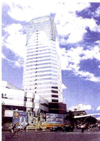
▲浙江省建行大楼基础工程
