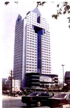
▲杭州市政府大楼基础工程
