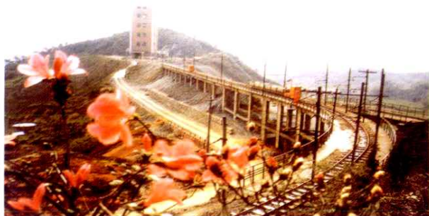
▲绍兴平水铜矿井塔楼和原矿运输线
