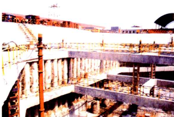
▲杭州第一高楼省长途电信枢纽楼基桩围护
