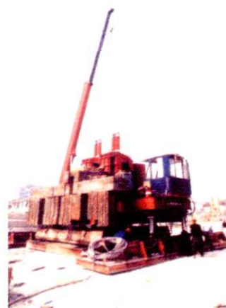
▲ 杭州涌金广场的静压桩施工
