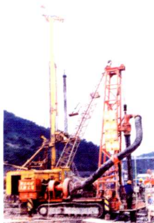
▲ 省地矿建设总包公司可施工 1.5~3米桩径的台湾 S500 自 行式反循环钻机
