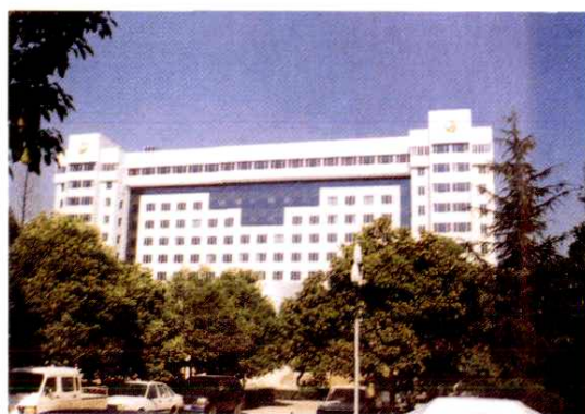
▲省府3号楼基础工程
