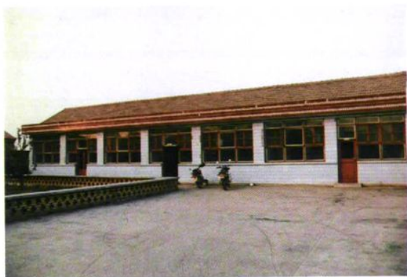
保岱镇供电营业所
