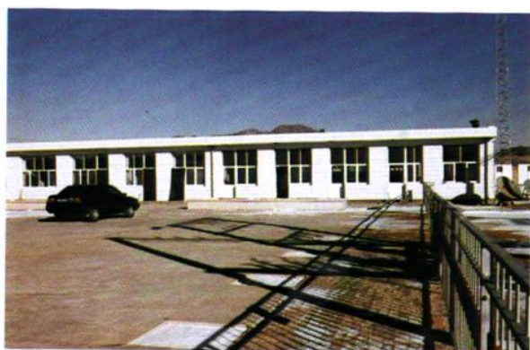
大堡镇供电营业所（与变电站同院）
