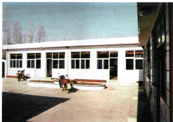
矾山镇供电营业所
