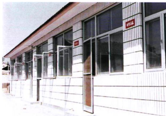
涿鹿镇供电营业所
