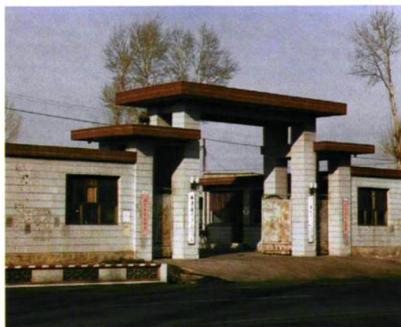
高堡电力仓库
