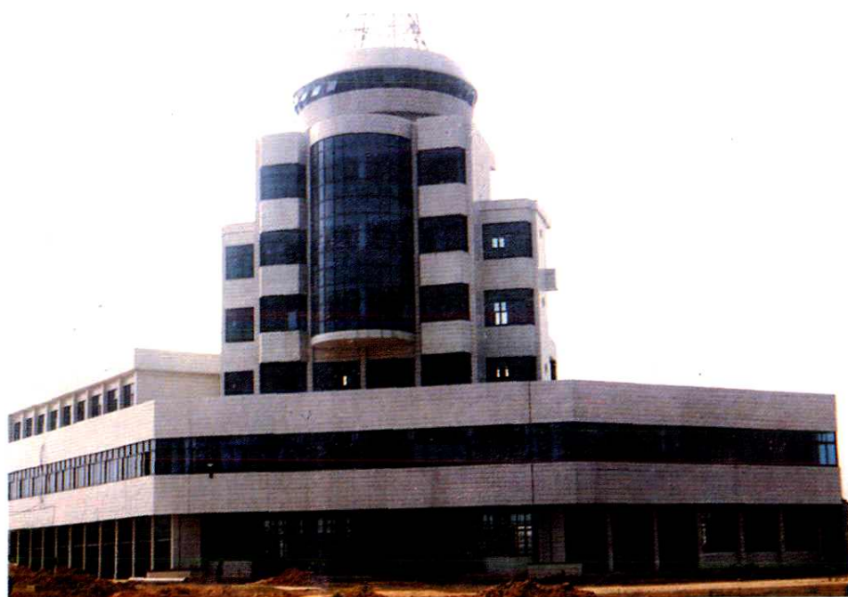
水边新县城程控大楼
