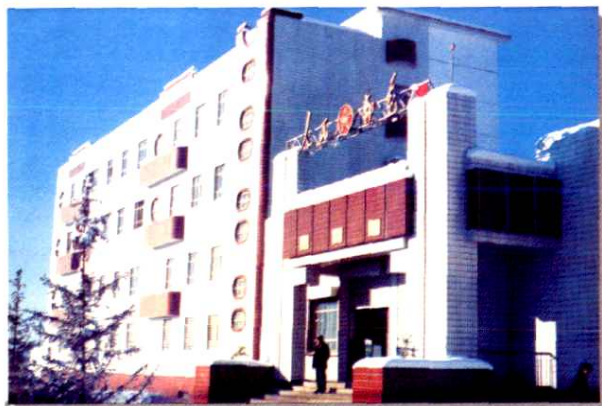
青河县邮电局综合生产楼
