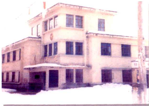
可可托海邮电局综合生产楼
