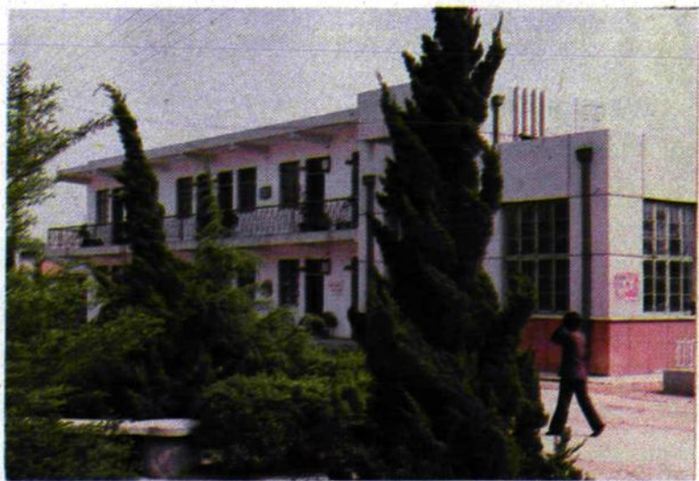
► 济南西铁路医院办公楼
