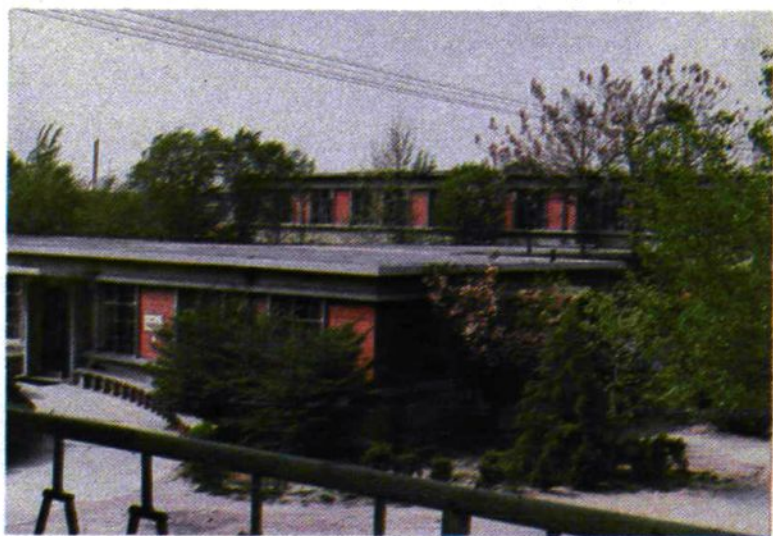
► 济南西铁路医院门诊病房楼
