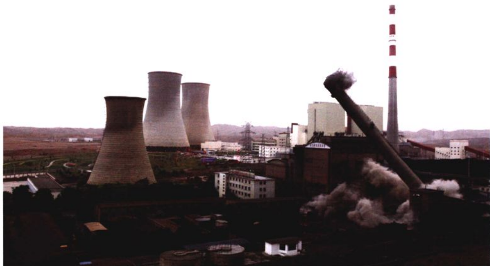
2007年6月16日,公司提前关停爆破了中宁电厂 2 \times 2.5 万千瓦小火电机组,此举成为宁夏关停小火电机组的“第一爆”。
