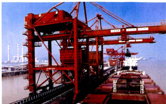
► 5万吨级专用运煤码头
