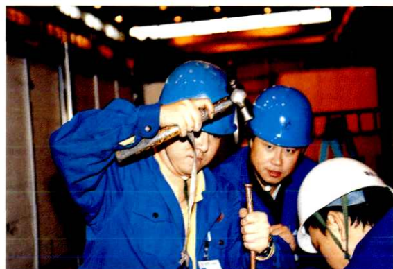
▲ 2000年11月, 2号机组 扩大性小修汽机检修现场
