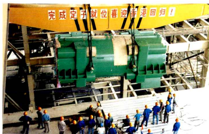
◀ 1997年6月, 3号发电机定子吊装就位
