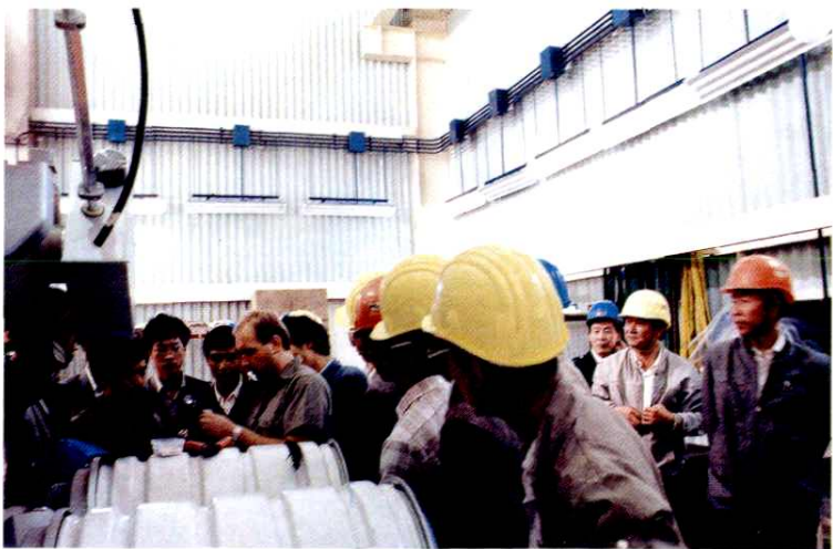
► 外国专家在现场指导升压站电气设备安装
