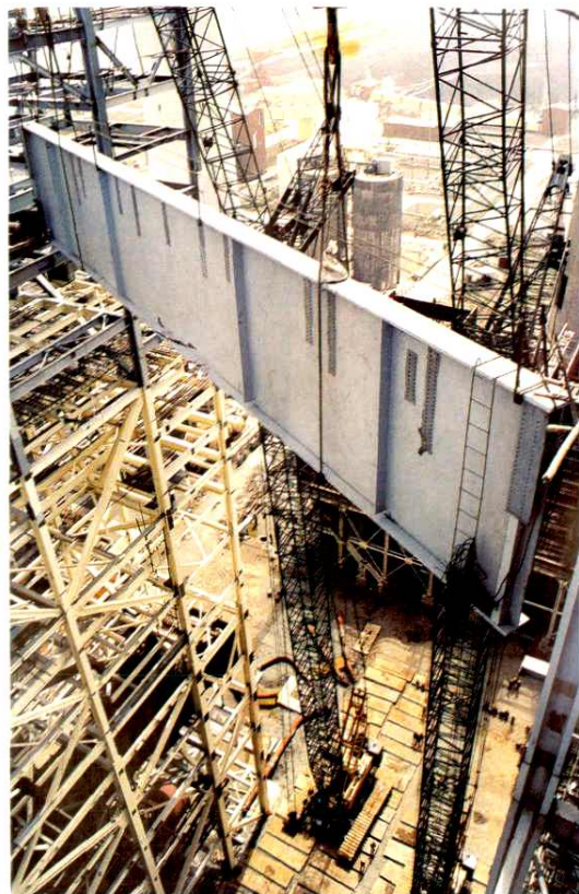
▲ 1992年4月12日，2号锅炉大板梁吊装就位
