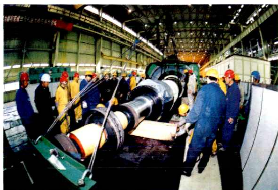
▲ 2000年2月, 3号机组进行检查性大修
