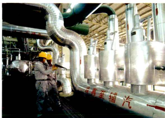
◀ 应用红外热像仪等监测手段, 实施设备状态监测
