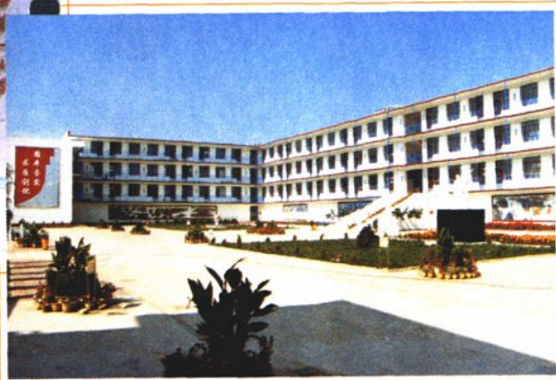
▲义教工程项目学校和林城关二完小教学楼（建于1999年）
