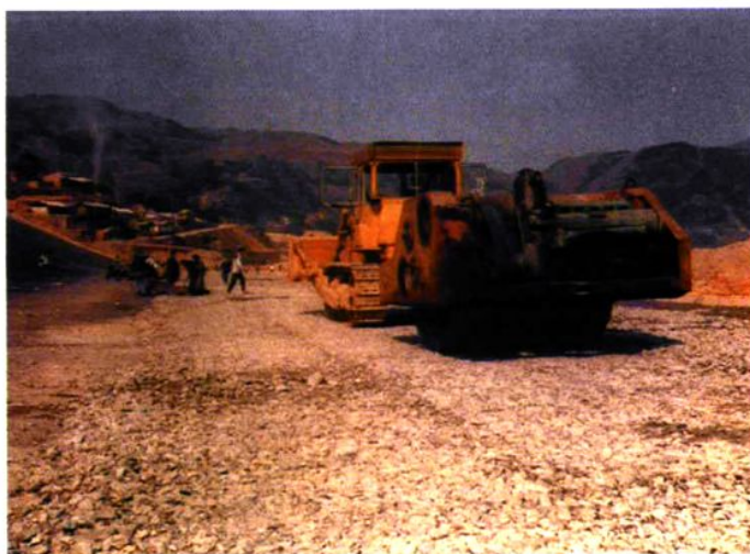
大坝压实施工
