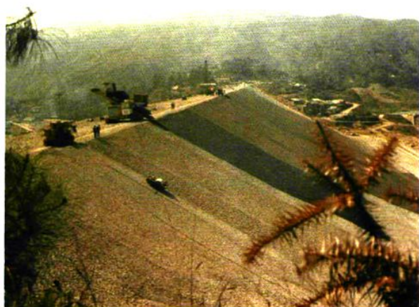
沥青砼斜墙施工
