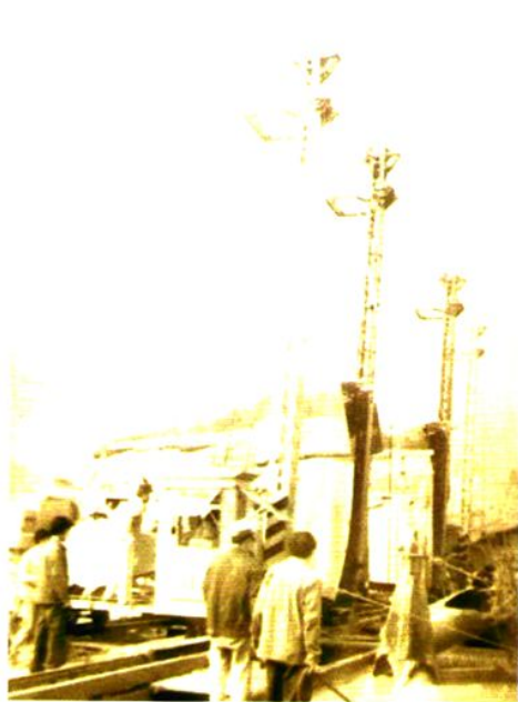
大坝基础乌卡斯施工
