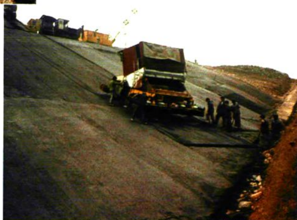
沥青砼斜墙施工
