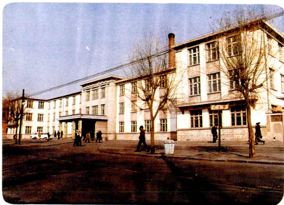
1965年建成的医院门诊楼
