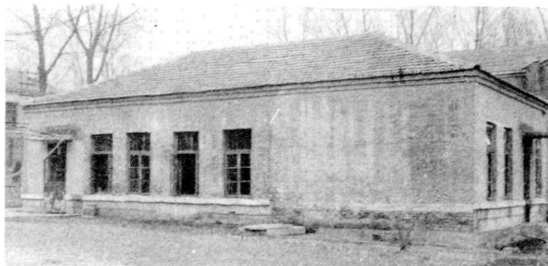
(图3) 开院时锅炉房
