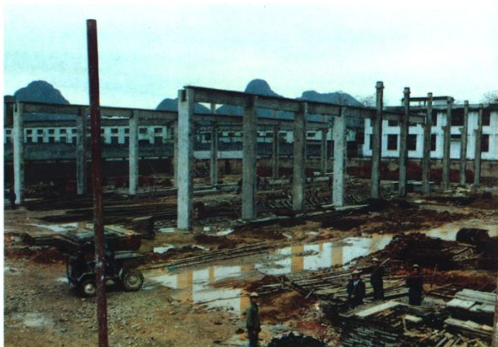
桂林啤酒厂筹备时期建筑工地一角
