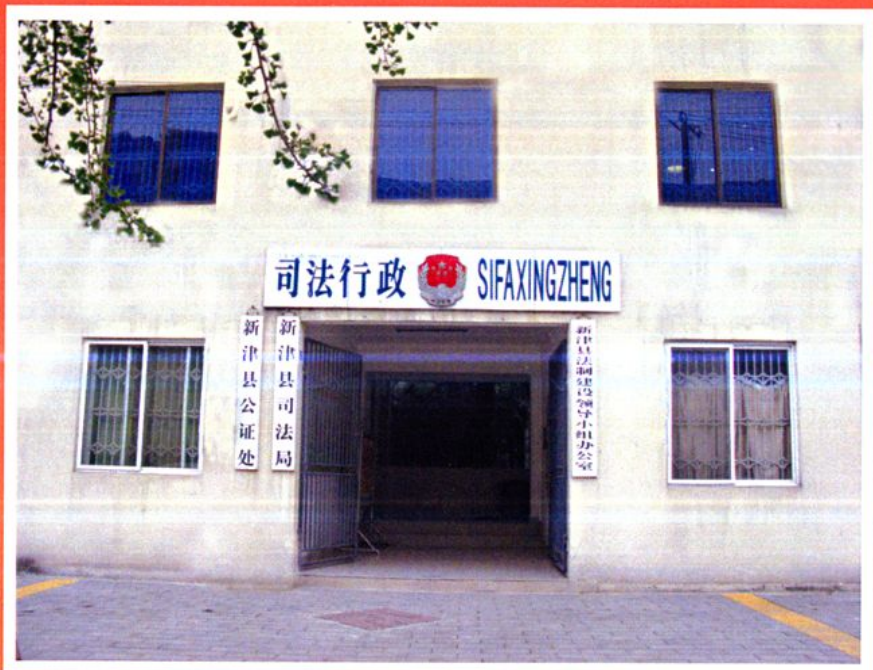
新津县司法局办公楼（五津镇瑞通路81号）
