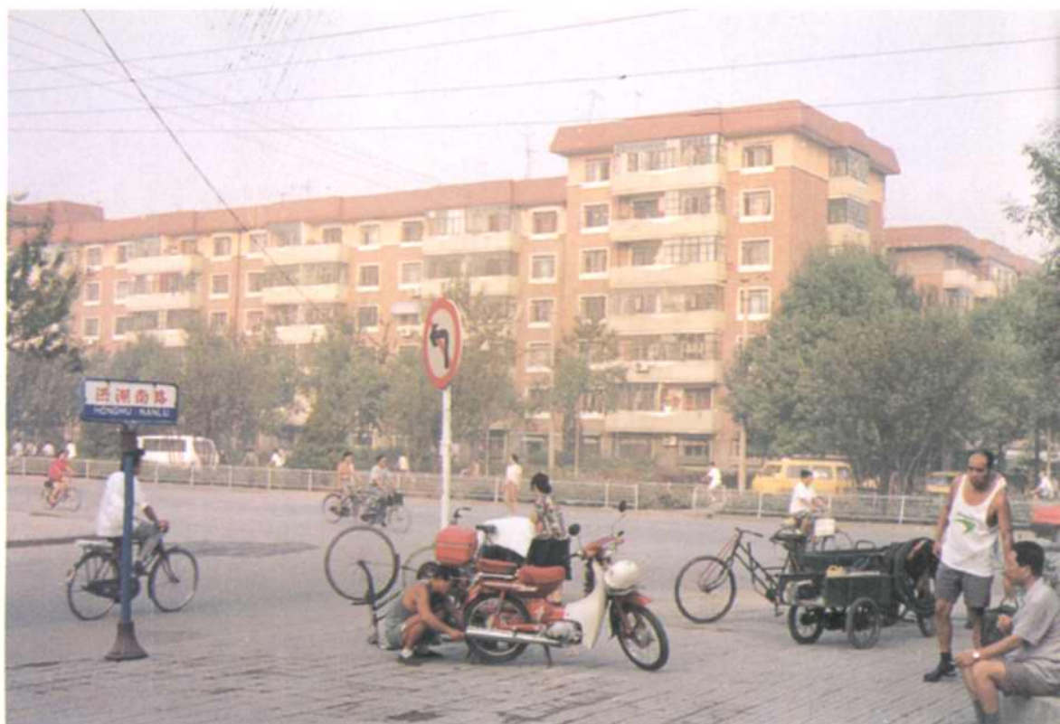
植物园住宅小区
