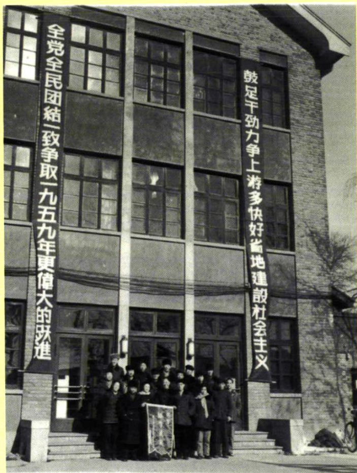
▲建所以后,我所曾一度在北京东四六条45号办公,图为当时所办公大楼。
