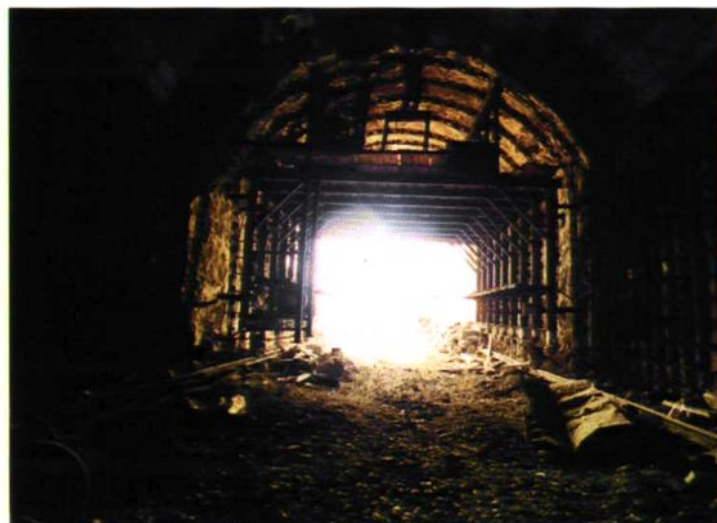
建设中的隧道
