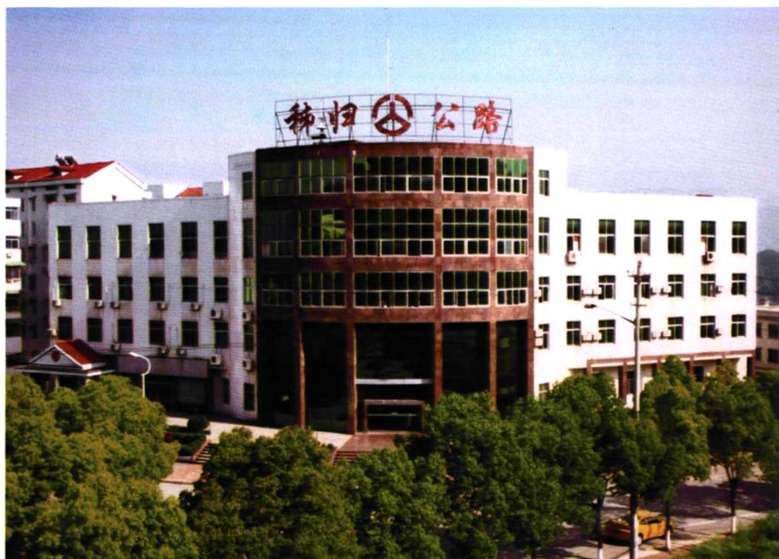
秭归县公路管理段大楼
