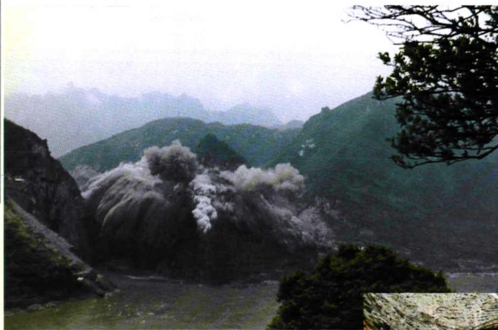
九畹溪大桥山体爆破
