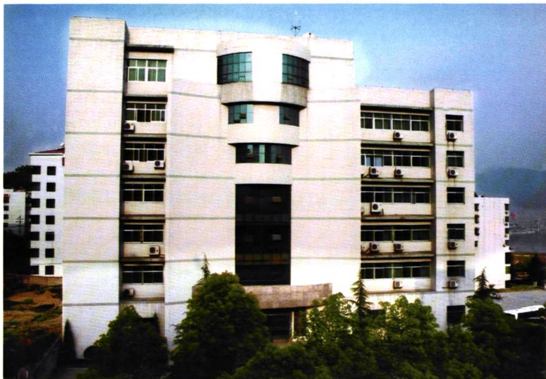
秭归县交通局办公大楼
