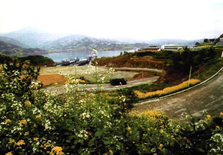
建设中的翻坝码头
