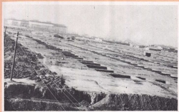
在施工中的第二金工车间（现三分厂）基础浇注完毕。
