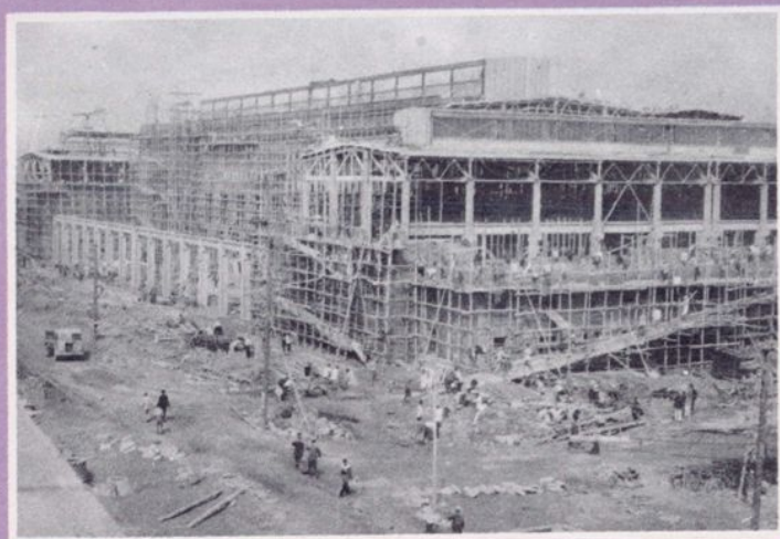
铸铁车间在紧张施工中（1958年）。
