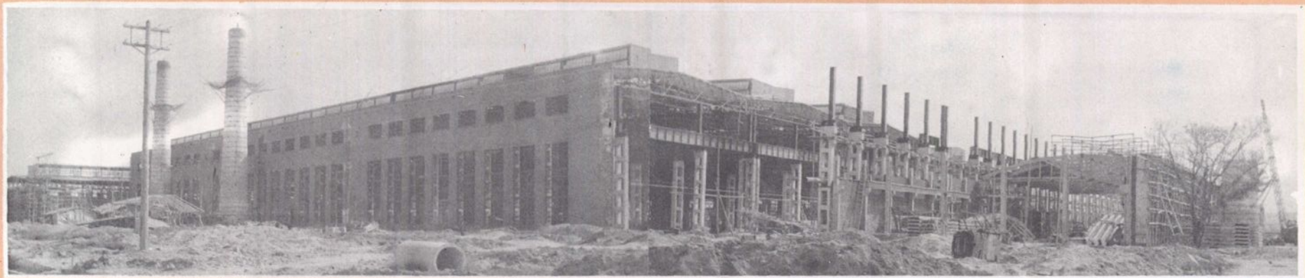
1959年容器车间（现二分厂）进入全面施工。
