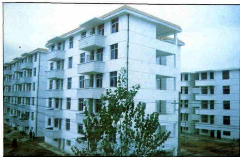
4 桂花建筑工程公司承建的成套商品房
