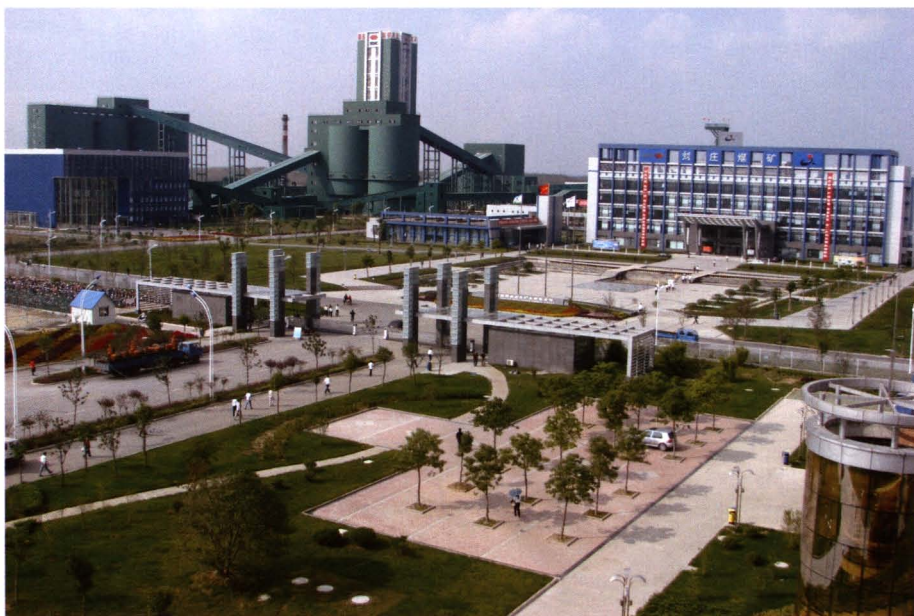
2003年，处先后承建国投新集公司刘庄矿副井、西进风井工程，获中国建筑工程“鲁班奖”
