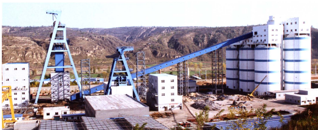
2008年，处承建陕西彬长矿区胡家河副井，创国内全深冻结最大井径外壁掘砌施工新纪录
