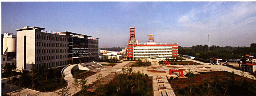
2004年，处承建兖煤菏泽能化公司赵楼矿井，获“国家银质奖”
