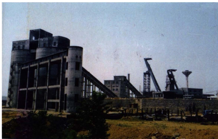
1995年，处承建的河南鹤壁矿务局冷泉副井，首次实施“项目法”管理
