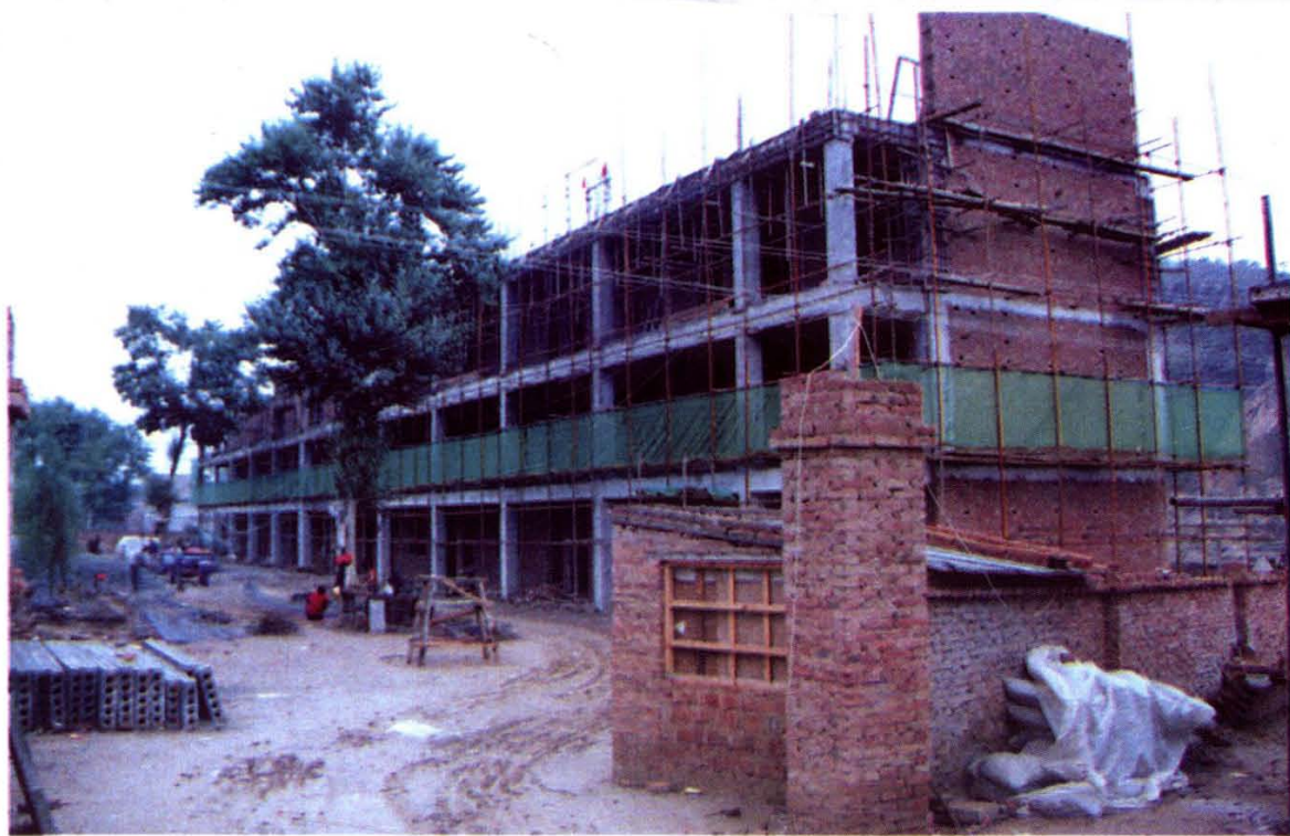
正在修建的四层教学楼
