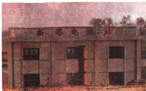
团结圩新港电排站
