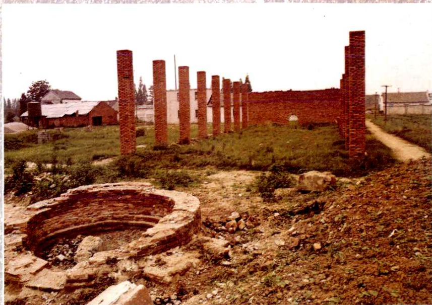
被停建拆除的砖瓦厂
