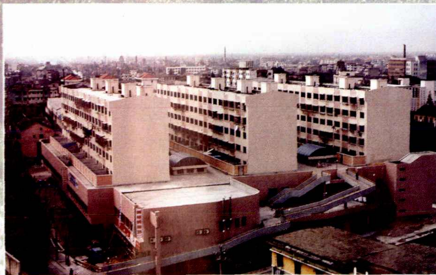
县城旧城改造1号 地块竣工
