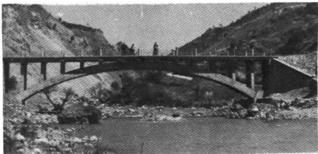
米子坪电站进厂公路桥(1979 年建)
