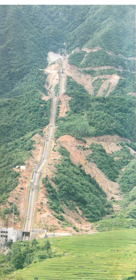
亚洲第一高水头电站——天湖 电站 官建中摄
