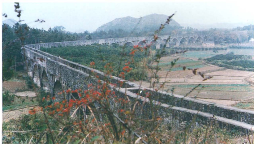
磨盘水库朝南乡大渡槽 蒋新能摄
