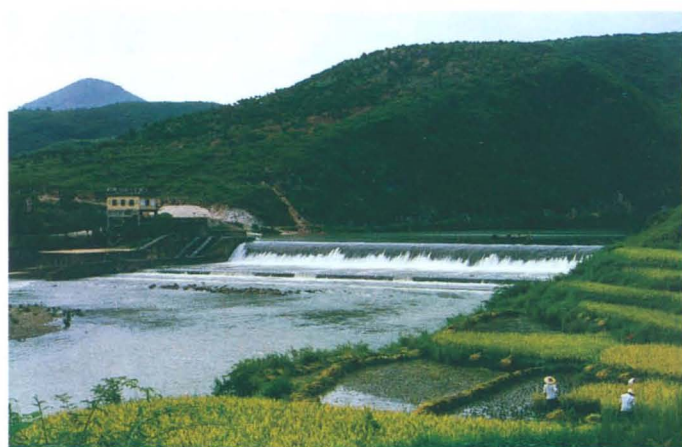
灌江引水工程拦河坝 蒋士贵摄
