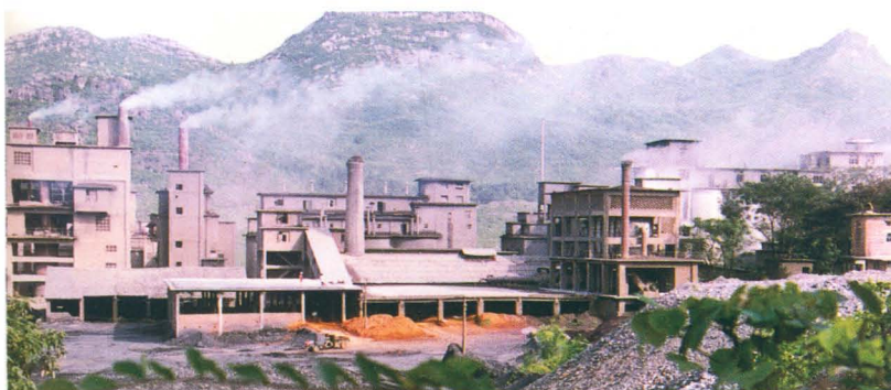
全州水泥厂生产车间 官建中摄
