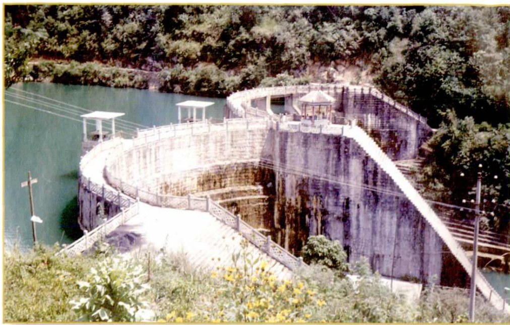
1989年10月建成投入使用的荔波甲良巴茶电站 (州水电局提供)
