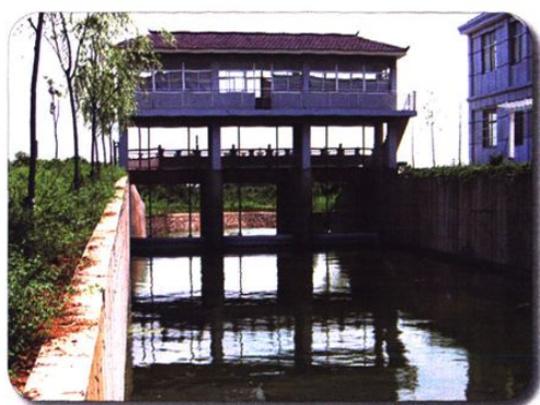
淳化东焦水库泄洪闸
