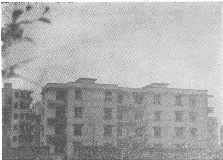
图1 新建卫生局办公宿舍大楼
