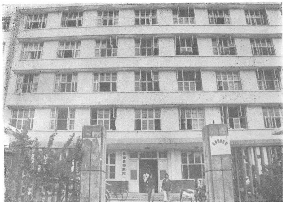
5 县中医院门诊部
