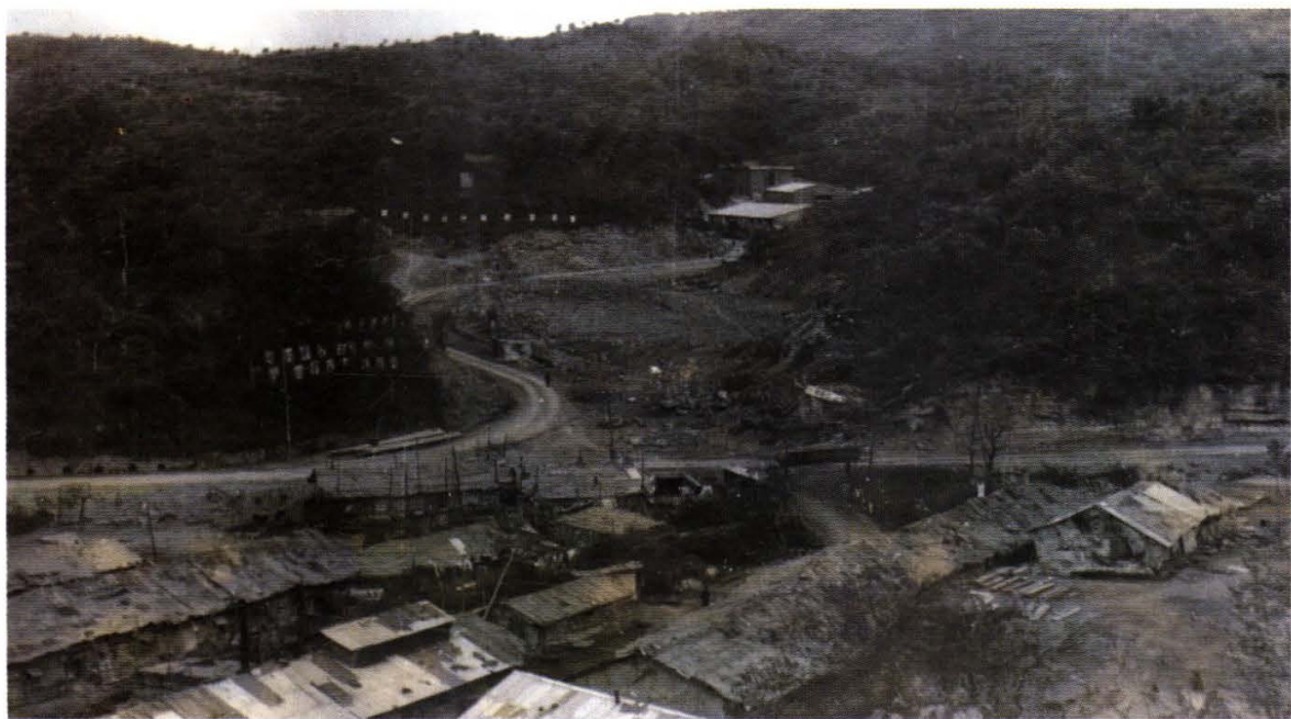
建设初期,工地建设者脚踏荒山,头顶青天,自己动手搭盖芦席棚,开始了艰苦创业历程。
