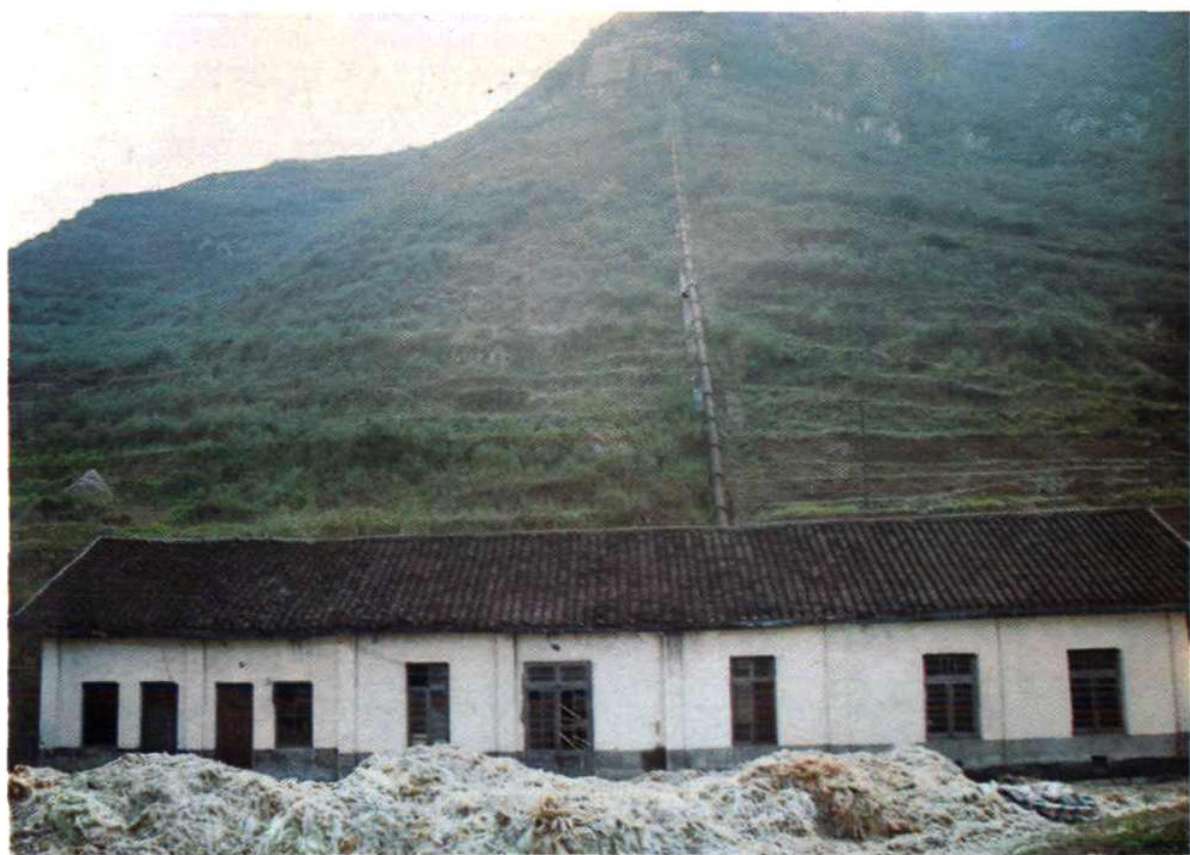
贵州省首座示范性农村水电站——兴义狮子山电站
