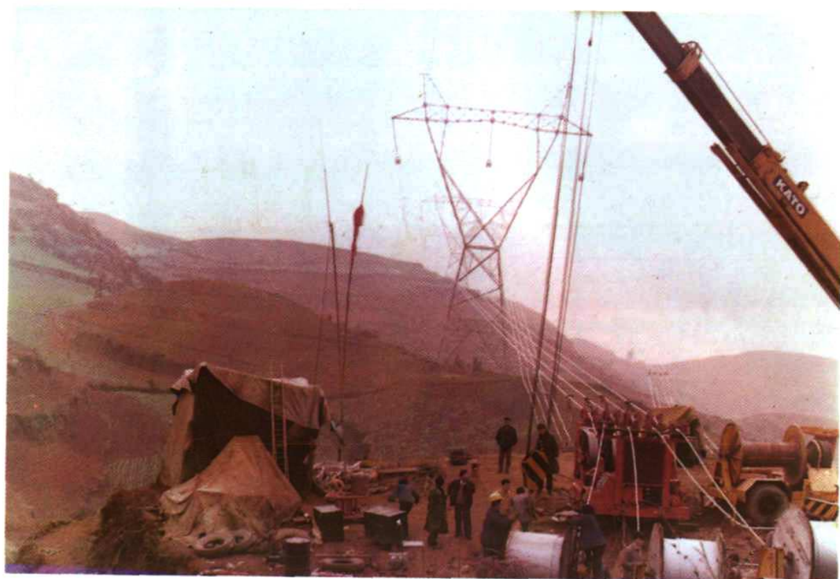
500 千伏天贵线施工现场
