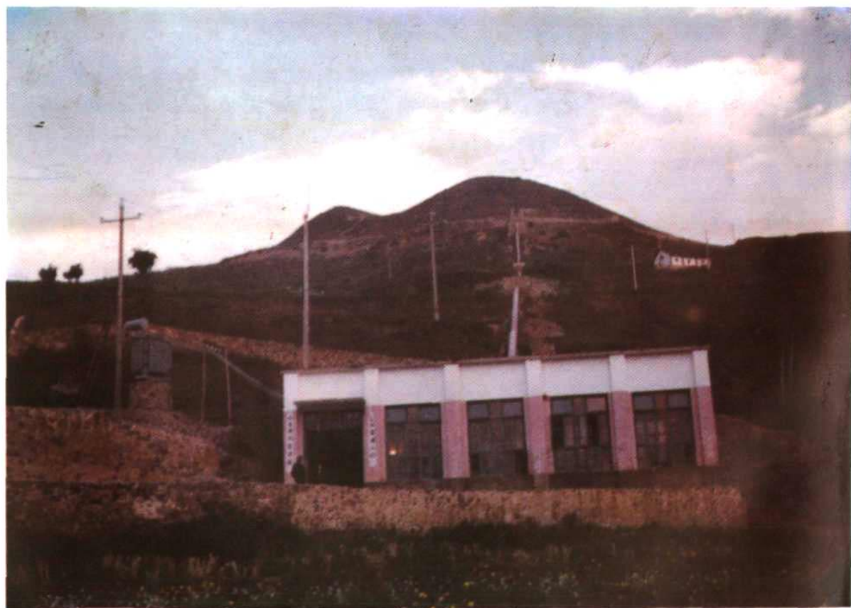
6 户农民集资兴建的 500 千瓦小寨电站
