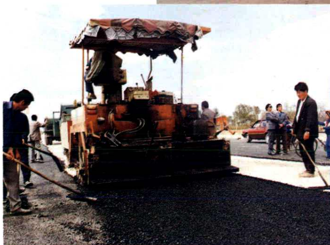
沥青砼摊铺作业
