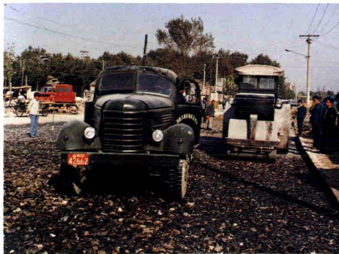
路基工程碾压
