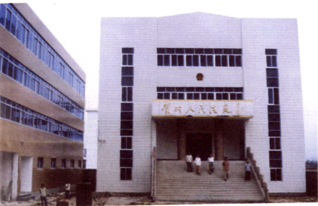
◀ 贺村人民法庭办公楼
