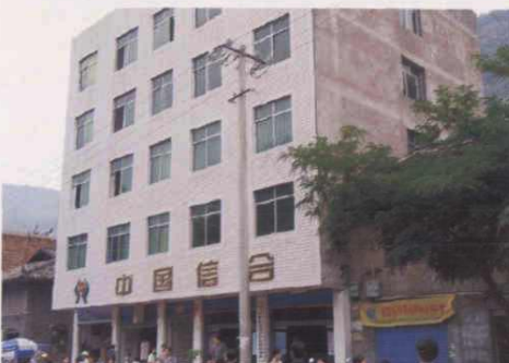
永安农村信用社泥溪分社综合楼
