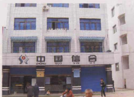
民胜农村信用社综合楼
