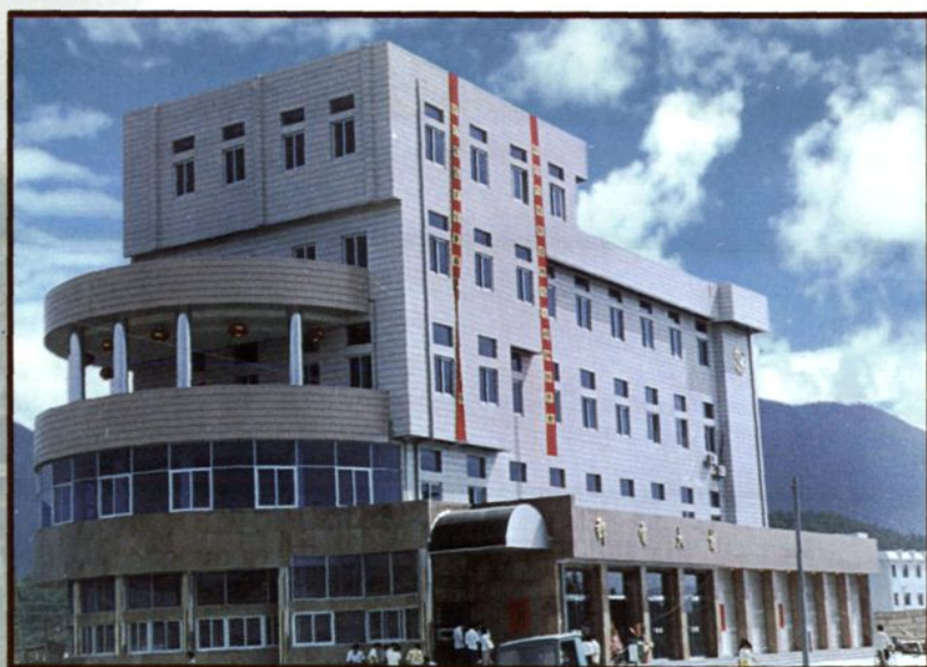
新建邮电支局大楼
