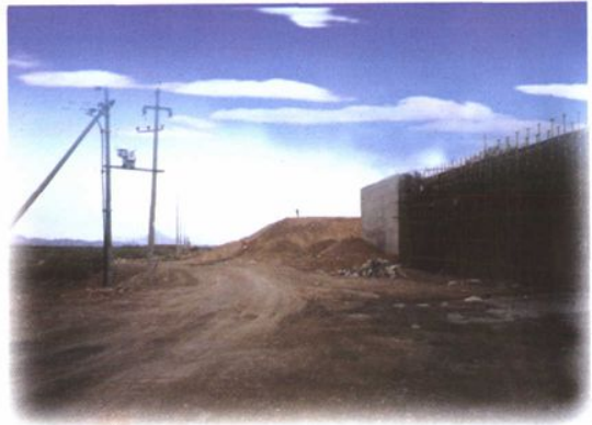
内蒙古交通厅局级10国道高速公路 新一麻段(正在建设中)
