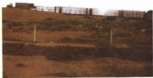
216省道乌达至巴彦浩特一级公路 (正在建设中)
