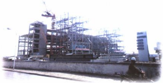
内蒙古蒙华海勃湾发电有限责任公司 第二期工程
