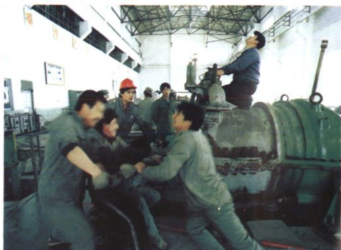
铺头热电厂2号机安装场景掠影
