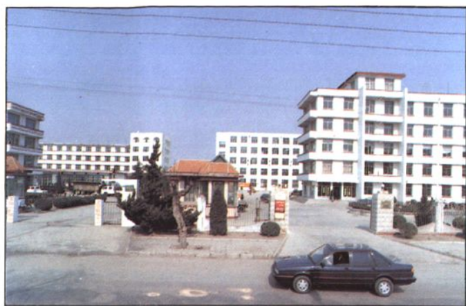
文登市电业总公司供电公司、用电管理所办公楼
