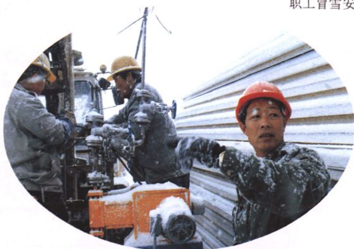
职工冒雪安装文登热电厂锅炉
